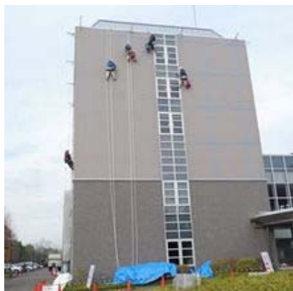
写真4. ブランコ足場/外装専科 web より
