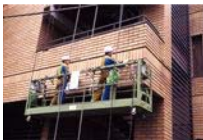
写真3. ゴンドラ足場/ビソーweb より
